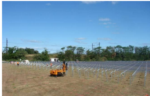
Figure 12 : Battage des pieux
