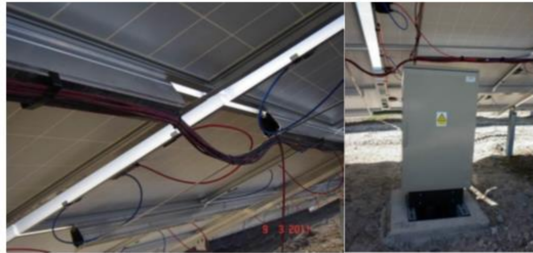
Figure 6 : Illustration du raccordement et d'une boîte de jonction
