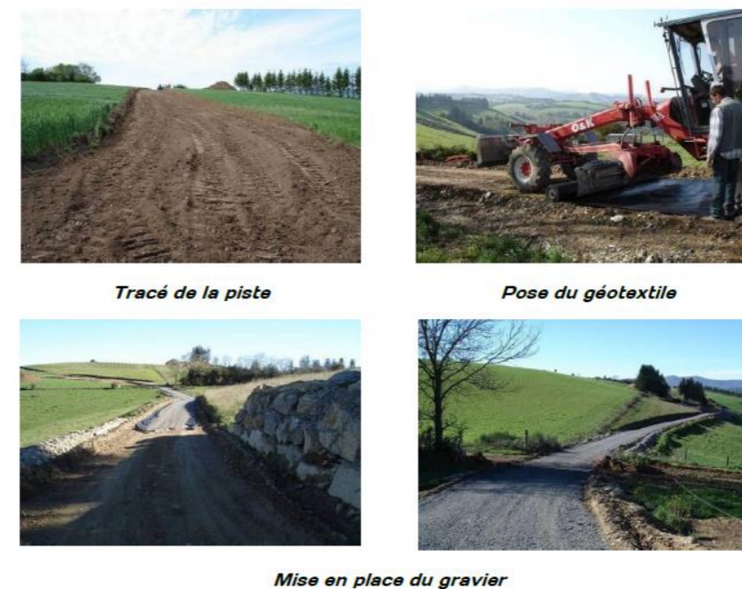
Figure 11 : Etapes de la création de pistes
