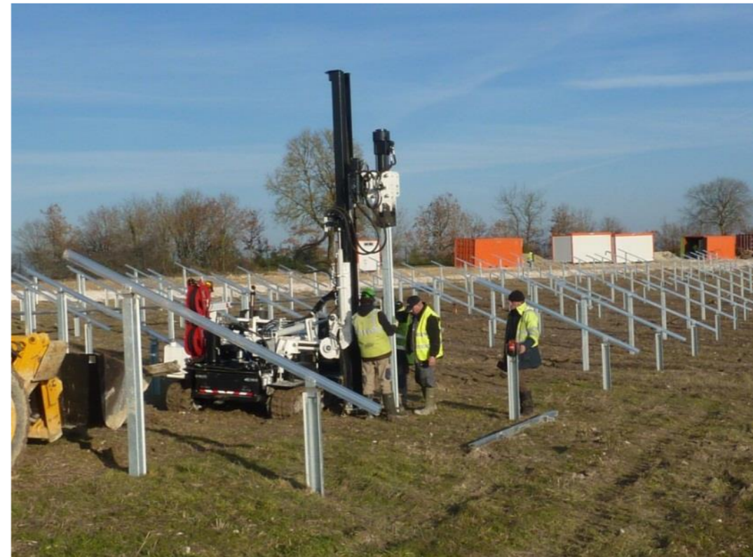
Figure 5 : Mise en place de support de panneaux
